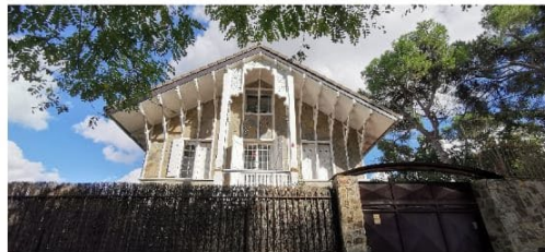
Exemple de vegetació a menys de 5 metres d'una teulada amb elements combustibles
