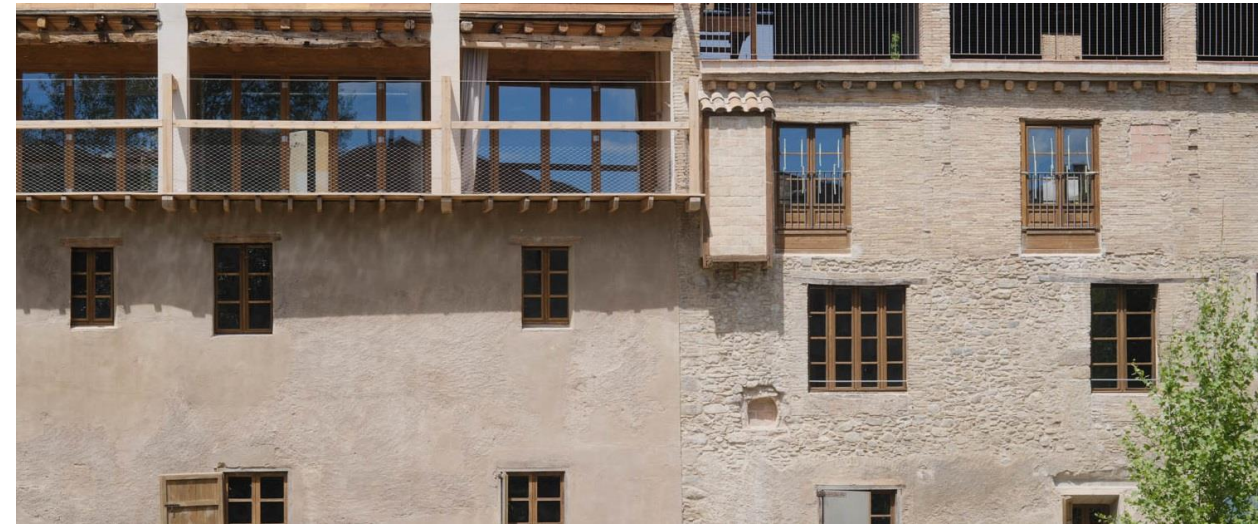
ADOBERIES 2. FAÇANA SUD (RIU)
