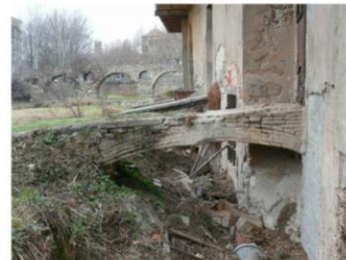
1710 (any de construcció) El canal i la resclosa en l'estat actual del Rech dels Pellaires
