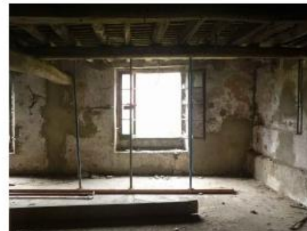
12. Finestra façana sud adoberia n°4.
