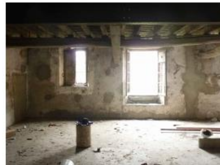
11. Finestres façana sud adoberia n°4.
