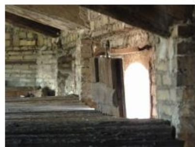
9. Detall de les portes corredisses de tancament. Adoberia nº2.
