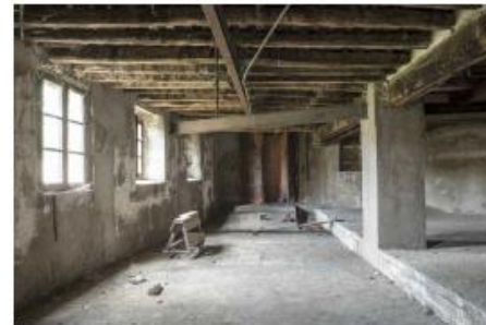
7. Vista entrada principal adoberia n°2.
