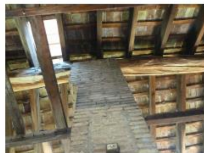
6. Detall de l'entrega del pilar central amb la jassera de la coberta de l'adoberia nº4.
