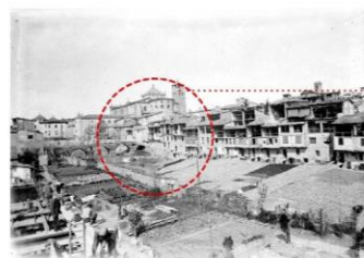
1900-30 Les adoberies ja es troben en procés de modernització. L'adoberia del cap del Pont no s'ha reconstruït i només queda la planta semienterrat. L'adoberia número 2 i 4 ja tenen un pis més d'ascendents. I és per això que comencen a tancar l'associació de la planta primera. (fotograf: Palmeria)
