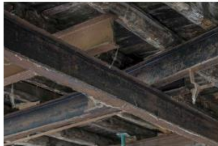
6. Detall estructura adoberia n°2.
