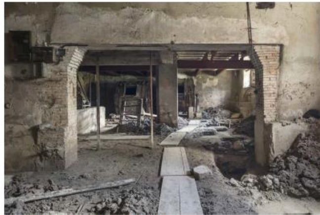
5. Vista a la mibgera entre l'adoberies n°2 i n°4. Àmbada del muntacàrregues.
