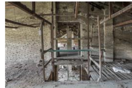
4. Vista de l'estructura del muntacarregues. Adoberia nº4.
