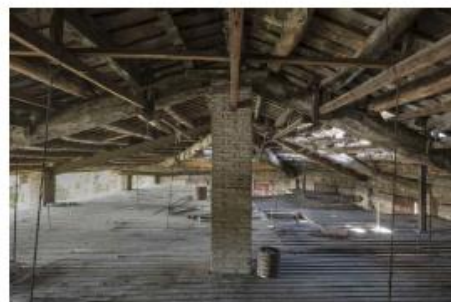
7. Vista de la coberta sobre els estenedors de l'adoberia nº2.
